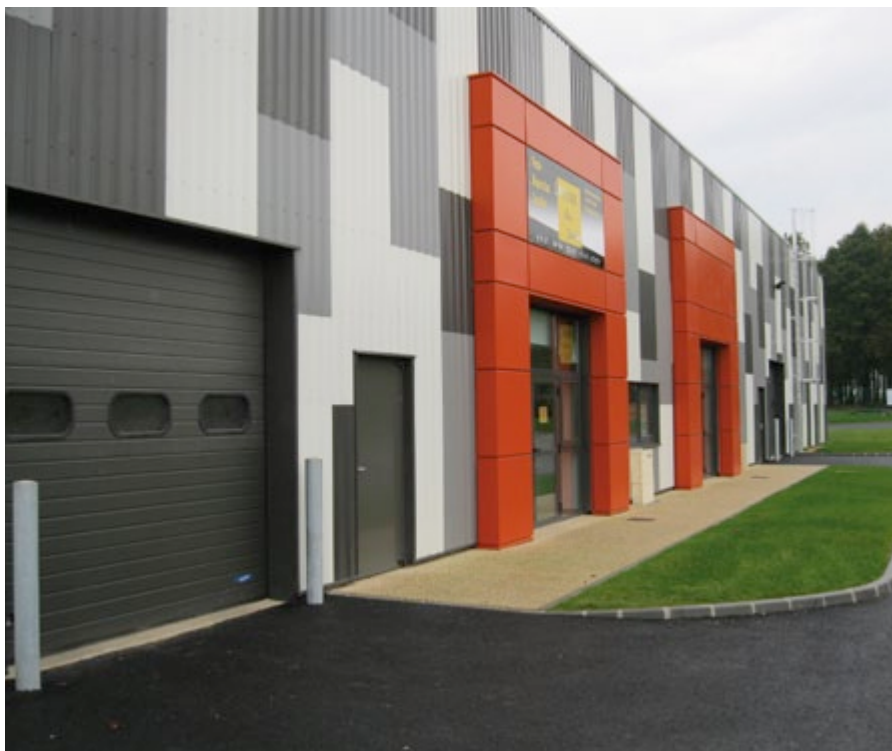
Exemple de réhabilitation réussie d'une friche industrielle à la Communauté de communes de Pipriac (35).
