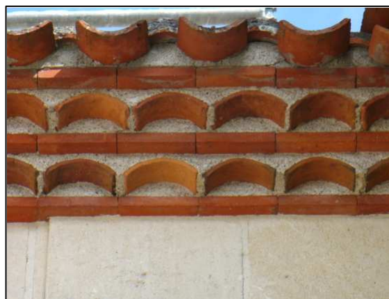
Une génoise : élément de la construction du toit formé de plusieurs rangs de tuiles creuses renversées et remplies de mortier
