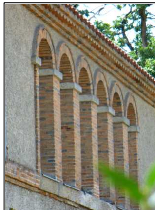
Une génoise : élément de la construction du toit formé de plusieurs rangs de tuiles creuses renversées et remplies de mortier
