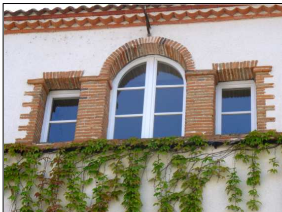
Une serlienne : une baie centrale, couverte d'un arc en plein cintre, accompagnée par deux baies latérales (reprise d'un type d'ouverture Antique par l'architecte Serlio à la Renaissance, d'où le nom)
