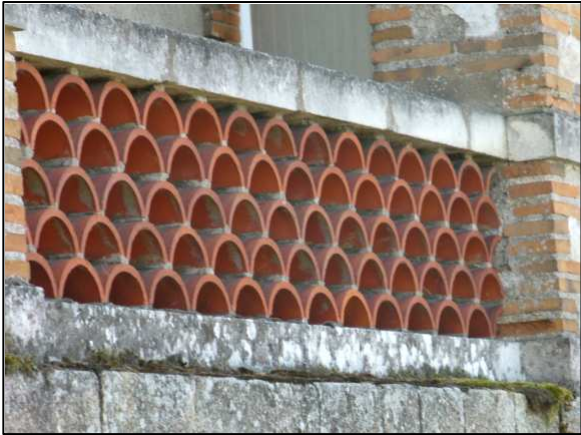
Garde-corps en claustra de « tuiles à l'antique » : posées en quinconce (claustra de tuiles creuses)
