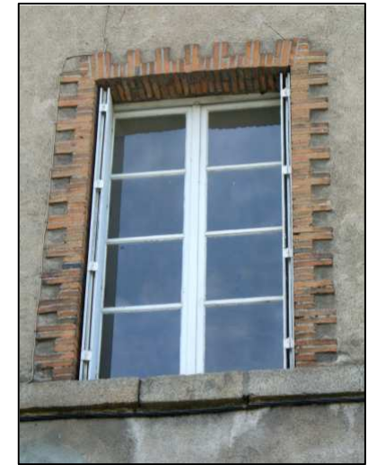
Autres forme de baie appareillée de briques chantignolles
