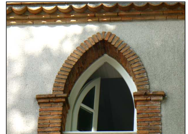
Baie en arc brisé appareillée de briques chantignolles (rare à Clisson, typologie plutôt gothique appliquée au style rustique à l'italienne)
