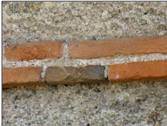
La Brique chantignolle utilisée à Clisson (le nom dérive de l'épaisseur de la brique appelée « chant » pour la chantignolle 3 cm maximum)
