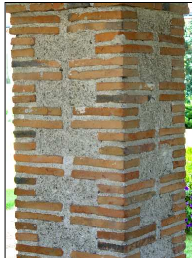
Pile carrée appareillée de briques chantignolles (chaînage d'angle alterné dit « en harpe »)
