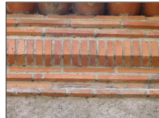
Exemple de corniche Couronnement d'une élévation formé de moulures en surplomb les unes aux autres
